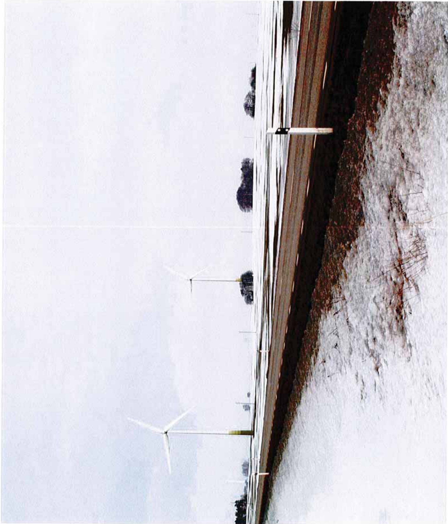
Fotomontage 1 - Hällstorp Tidpunkt: 2010-03-08 Verk: Enercon E 82 Tornhöjd: 87 meter Avstånd till närmsta verk: 960 m Optik: 50 mm
