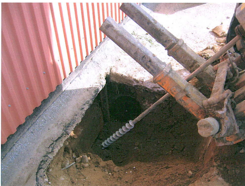
Snedborring (0802) under lunchrummet vid Lans Mekaniska Verkstad.
