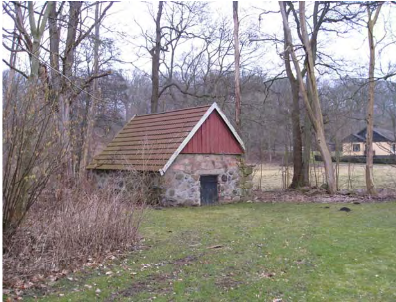
Figur 99: Foto över solitärbyggnaden. Byggnaden ses på utformningsplanen i figur 93.
