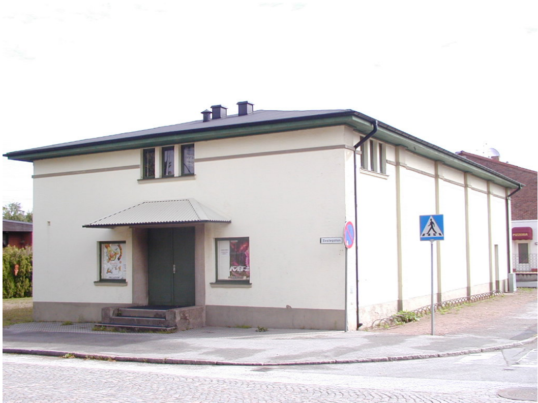
Kulturhusets entré med skärmtaket kvar. Bilden är tagen för några år sedan.
