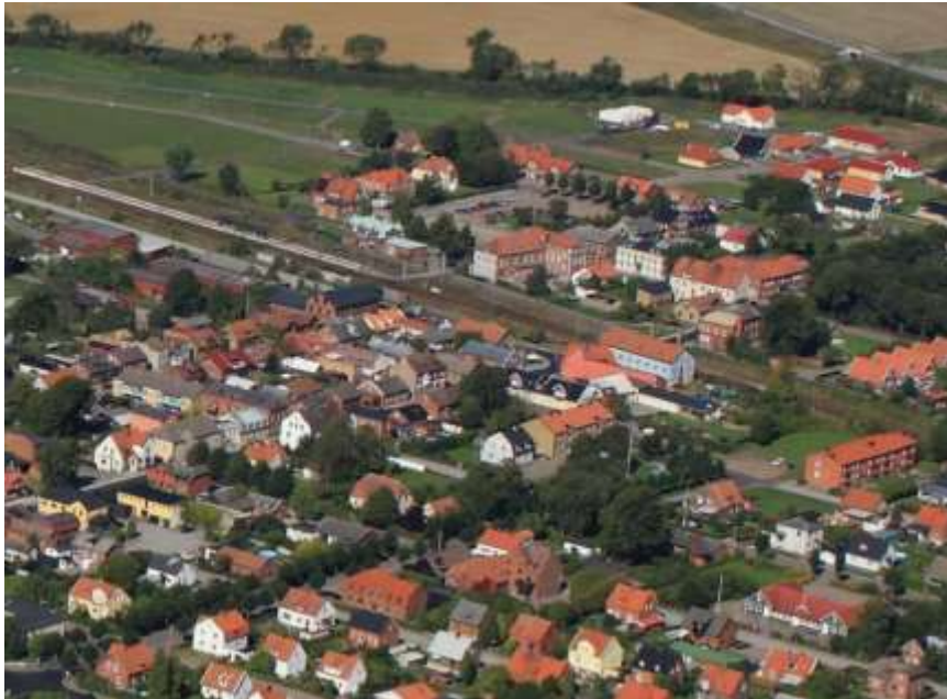
Kulturmiljön omfattar Teckomatorps centrala delar.
